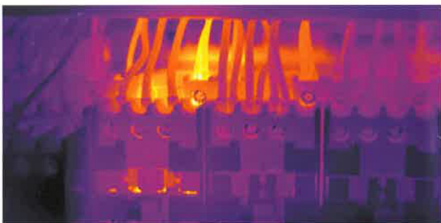
Manutenção preventiva de instalações elétricas.
